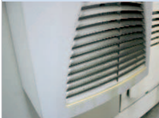
Ohne RiNano: Die ölhaltige Umgebungsluft hinterläßt deutliche Verschmutzungen.
